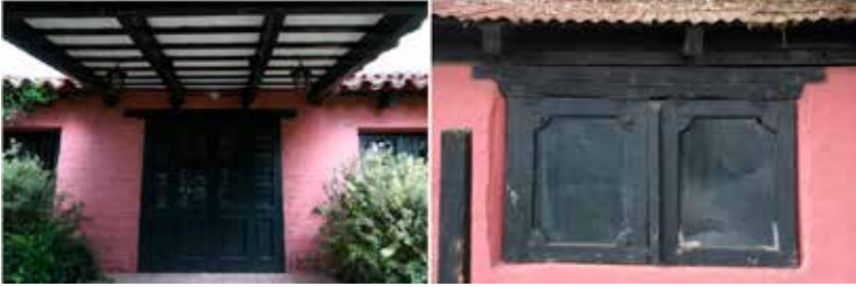
Tanto puertas y ventanas originales de la época, se estima 1830
