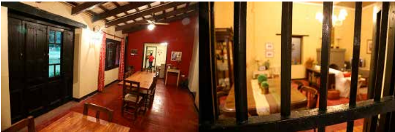
Las puertas ventanas, con vidrio y postigones. También se puede apreciar la construcción con adobones por el ancho de las paredes.
