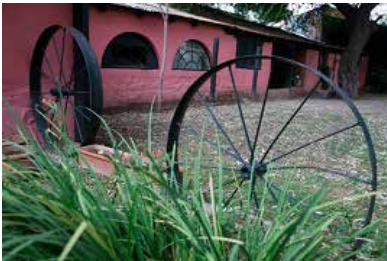
El Costado con ventanales modificados
