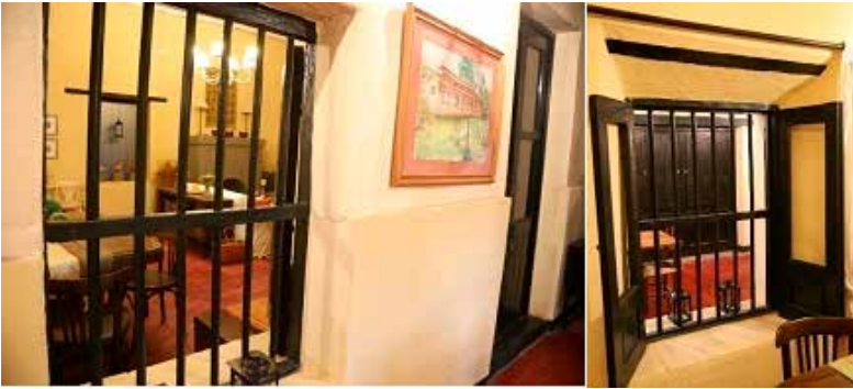
Se advierte que las rejas de los ventanales son de madera, típico de la época
